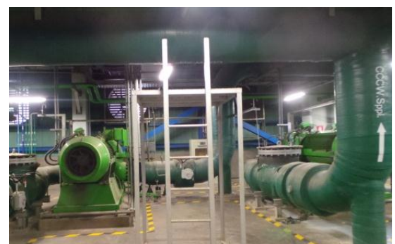
รูปที่ ค-3 การหล่อเย็นระบบหล่อเย็นแบบปิด (Closed Cycle Cooling Water System) ด้วย Absorber เพื่อลดระดับเสียง
