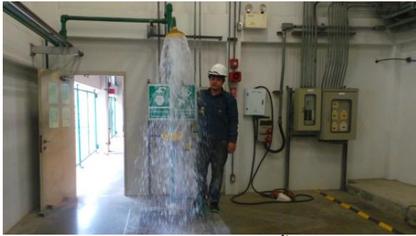
รูปที่ ค-12 การติดตั้งอุปกรณ์ชำระล้างฉุกเฉินบริเวณที่ต้องทำงานสัมผัสกับสารเคมี
