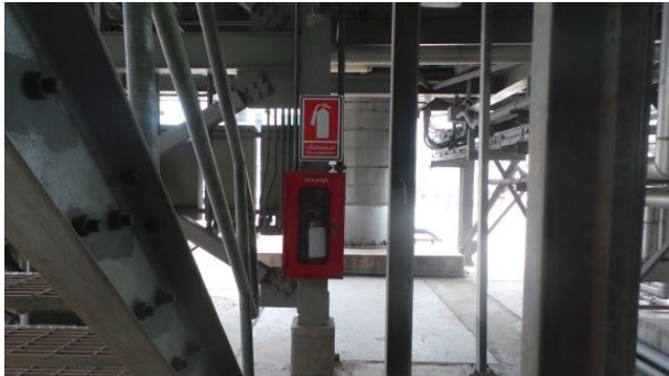
รูปที่ ค-13 การติดตั้งอุปกรณ์ดับเพลิงให้ครอบคลุมพื้นที่ต่างๆ ในโรงไฟฟ้า
