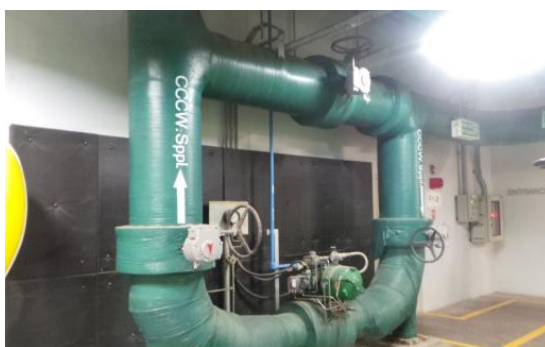
รูปที่ ค-3 การหล่อเย็นระบบหล่อเย็นแบบปิด (Closed Cycle Cooling Water System) ด้วย Absorber เพื่อลดระดับเสียง
